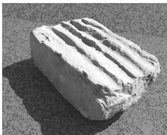
3 pav. Vilniaus Švč. Mergelės Marijos (pranciškonų) bažnyčios plyta su išilginėmis braukomis.
