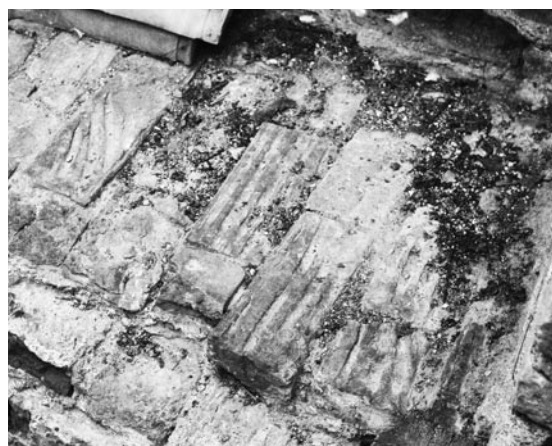
7 pav. Vilniaus Kalvarijų bažnyčios brauktinės plytos, sumūrytos pietų bokšto langokraščio apačioje.
