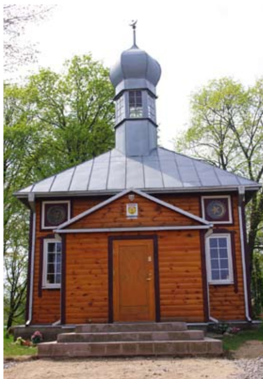
13 pav. Nemėžio mečetės šiaurinis fasadas po 2009 m. rekonstrukcijos. Eglės Ročkaitės 2013 m. nuotrauka
